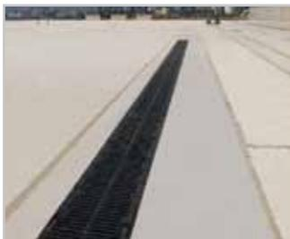
Ubicados en los muelles y en las diferentes instalaciones, que permitan recoger las aguas de lavado, derrames de aceites de vehículos y grúas, derrames de combustible. Estas redes se deben conectar con tanques donde se depositen estos residuos para su posterior tratamiento.
