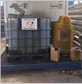
Para recoger los derrames que se puedan producir durante el depósito de residuos líquidos es importante disponer de elementos, bajo los contenedores, para la recogida de dichos potenciales vertidos, como se puede ver en la imagen.
