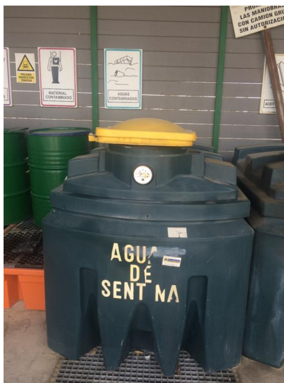
Figura 14: Contenedor de agua de sentina del punto limpio de Sancti Petri.
