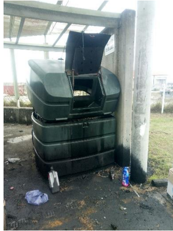
Figura 29: Contenedor de aceites roto en el punto limpio del puerto de Cudillero.
