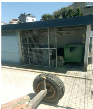
Figura 22: Punto limpio del puerto de Figueras.
