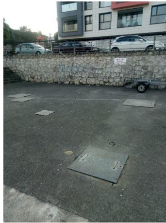
Figura 7: Depósitos para la recogida de residuos líquidos MARPOL en Ribadesella.
