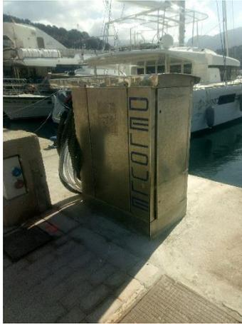
Figura 34: Bomba de aspiración de aguas de sentina en Port de Soller.
