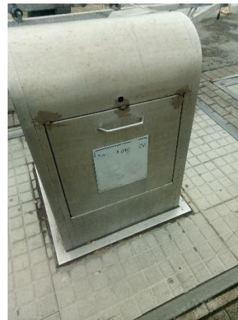
Figura 9: Contenedor soterrado de residuos orgánicos en Castro Urdiales.
