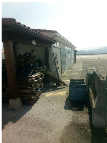
Figura 22: Punto limpio de San Vicente de la Barquera.
