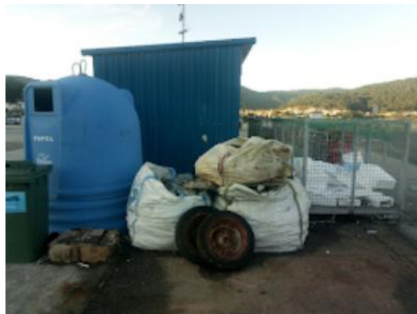
Figura 31: Vista general del punto limpio del puerto de Muros.
