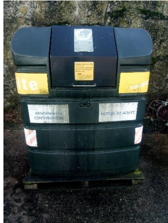
Figura 10: Contenedor de aceite usado, filtros de aceite y absorbentes contaminados en el puerto de Aguiño.
