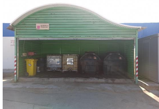
Figura 6: Punto limpio del puerto de Mazarrón.
