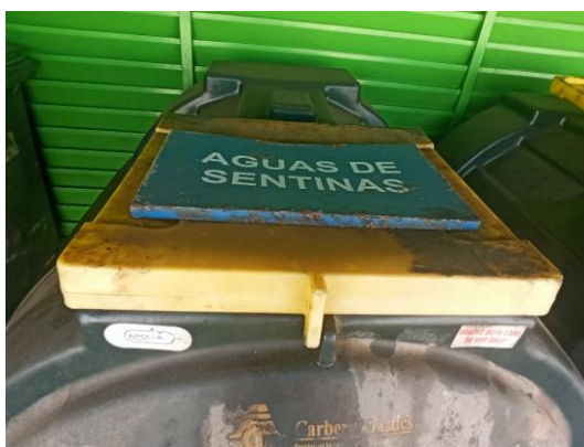
Figura 10: Tapa del contenedor de aguas de sentina del punto limpio del puerto de Cabo de Palos.
