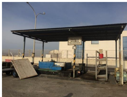
Figura 8: Estación de punto limpio del puerto pesquero de Almería.
