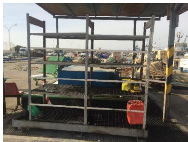
Figura 16: Estantería para envases de residuos peligrosos de la estación de punto limpio del puerto de Motril.
