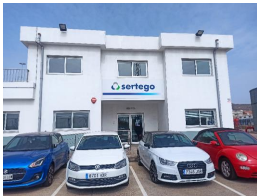
Figura 6: Planta de tratamiento de residuos MARPOL I en el puerto de Las Palmas de Gran Canaria.
