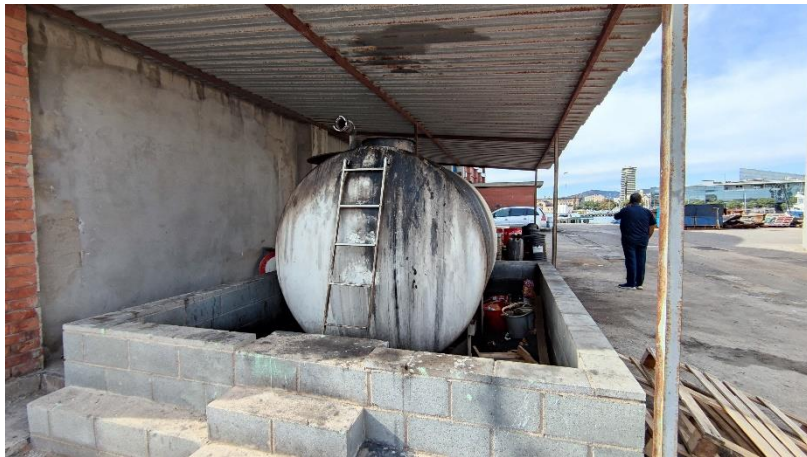
Figura 13: Punto limpio con residuos pesqueros en el puerto de Barcelona.
