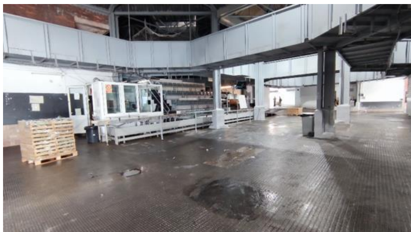
Figura 1: Lonja del puerto de Barcelona.
