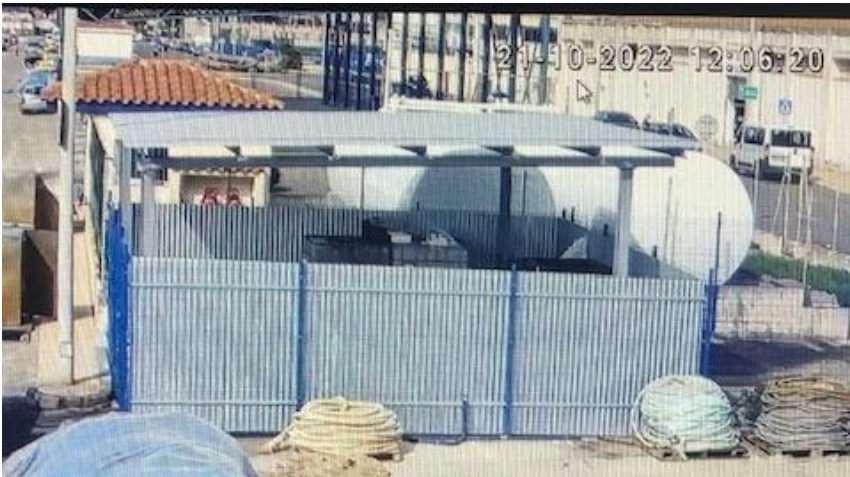
Figura 24: Punto limpio del puerto pesquero de Castellón.
