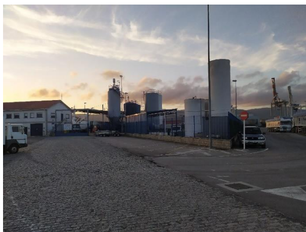
Figura 5: Planta de Codisoil S.A. en el puerto de Marín.
