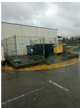
Figura 17: Punto limpio del puerto de Ferrol.
