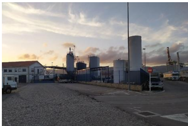
Figura 20. Planta de Codisoil S.A. en el puerto de Marín (Galicia), donde se tratan los residuos MARPOL I
