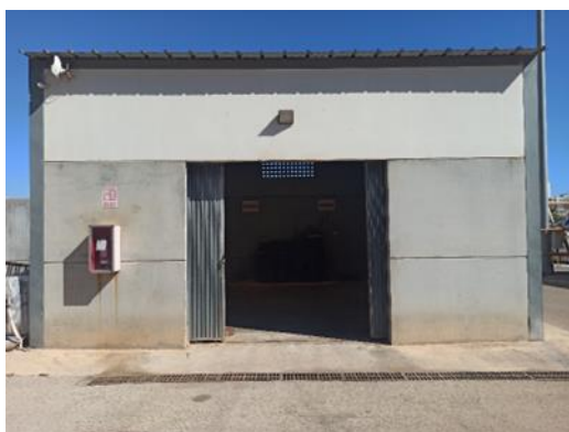
Figura 26. Edificio del punto limpio del puerto de Gandía (Comunidad Valenciana)
