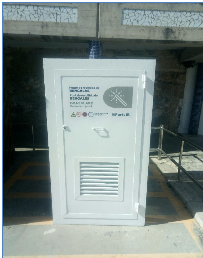
Punto de almacenamiento de residuos de bengalas
